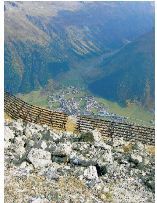
Blick auf Galtür vom Grieskogel über die Lawinenverbauungen hinweg. An diesem Berg löste sich die zerstörerische Lawine im Winter 1999.
