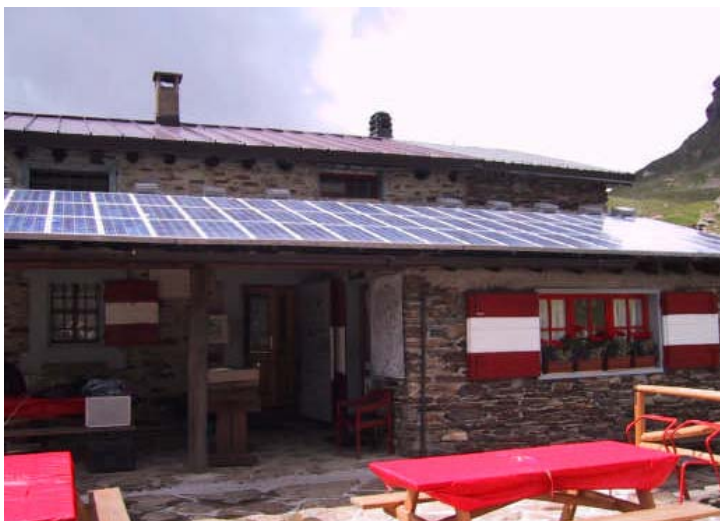
RIFUGI: campo fotovoltaico installato su tettoia
