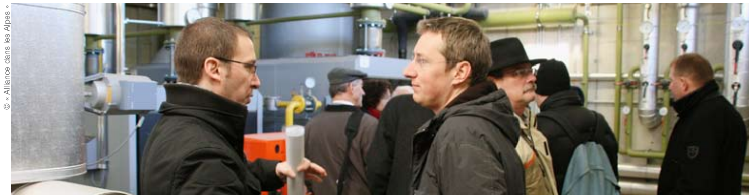
Quelles stratégies pour les communes face au changement climatique ? Visite de la chaufferie collective à biomasse de Götzis/A, dans le cadre de la conférence « Les communes font le climat ».
